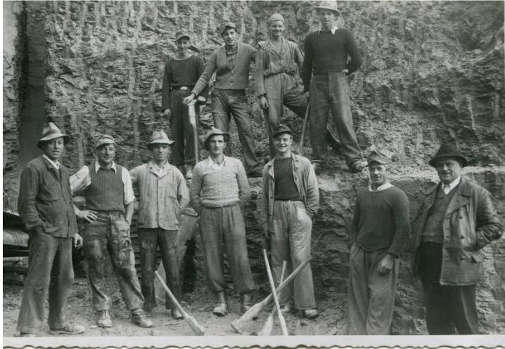
1898 wird mit dem händischen Tonabbau begonnen. Die Hauen dazu wurden speziell im Stubai geschmiedet. 150 Saisonarbeiter aus dem Friaul erzeugten mit Handschlag Normalziegel (25x12x6,5 cm), trockneten sie an der Luft, brannten diese mit Holz in einem mit Erde bedeckten Feldofen, damit wird das Ziegelwerk aufgebaut. In der Folge wird in einem ovalen Ringofen, in welchem mit
